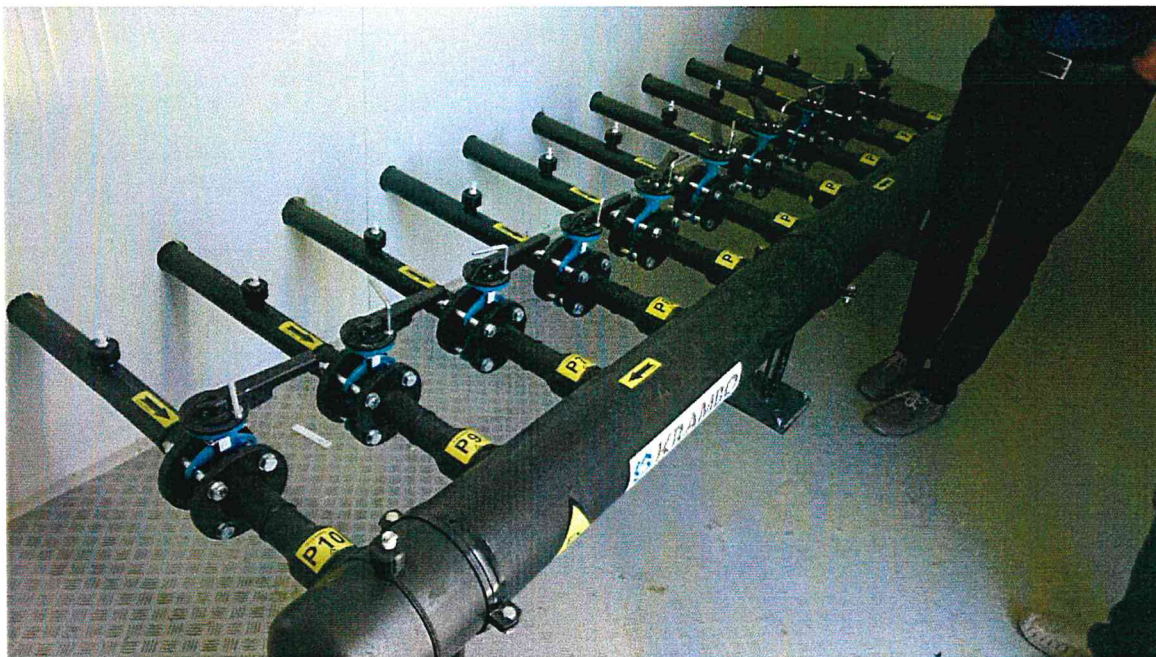
Figura 7 substație de colectare în proiecte similare 10 intrări
