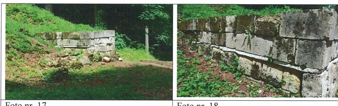
Fețele expuse spre sud sunt acoperite în proporție foarte redusă de creșterile biologice, iar pe fețele orientate spre de vest, predominant un biofilm format preponderent din alge verzi (Foto nr. 19). Printre blocurile de piatră și în cavitățile acestora s-au dezvoltat mici plante ierboase, insectele și șopârlele găsindu-și adăpost în aceste spații (Foto nr. 20).
