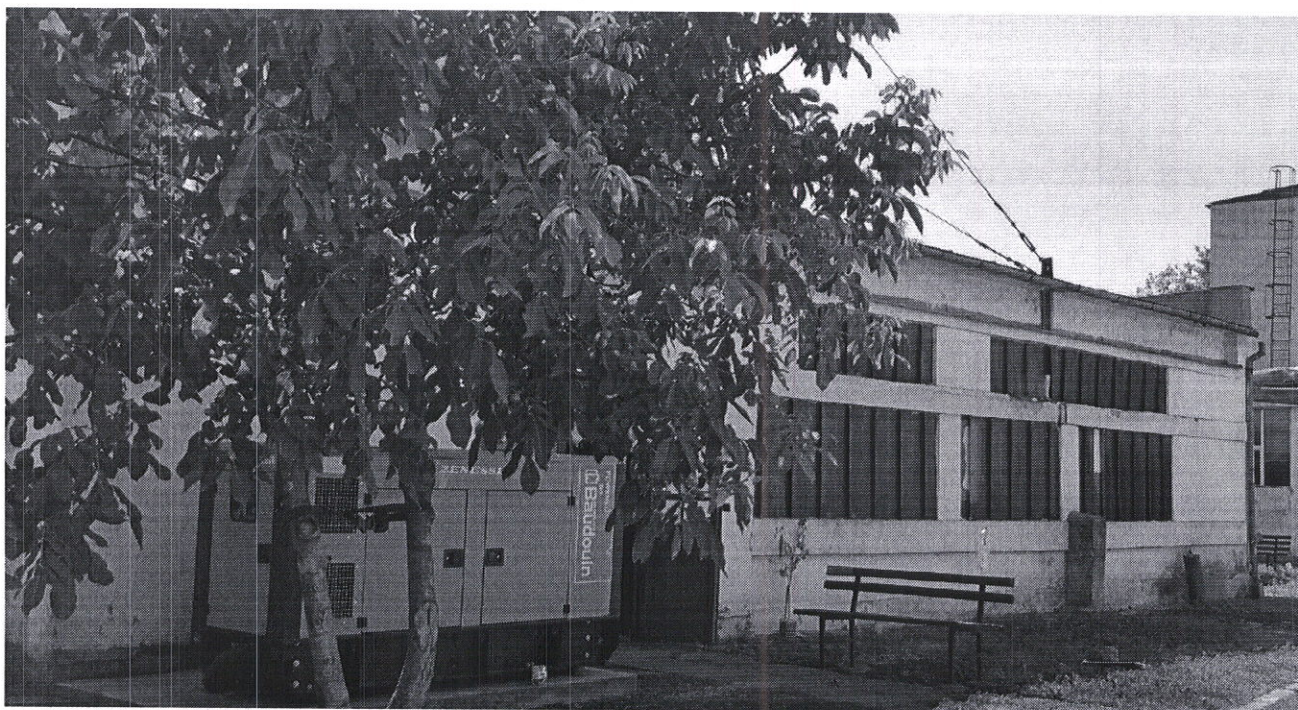
Foto 5. – Centrala Termica C4
