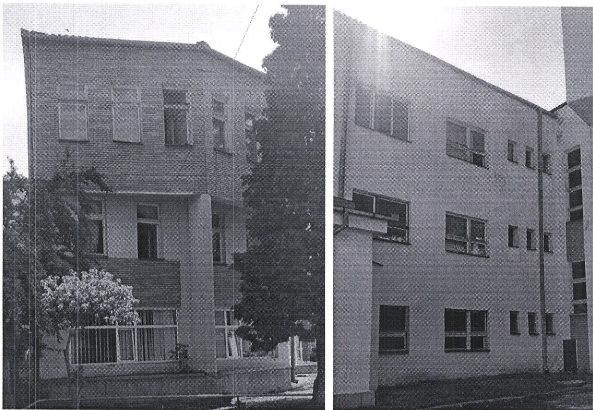
Foto 1. – Corp Tratamente C1+C2
