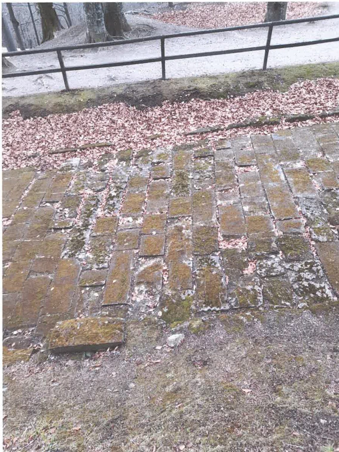
Foto 7 – Vedere de detaliu a Drumului Pavat
