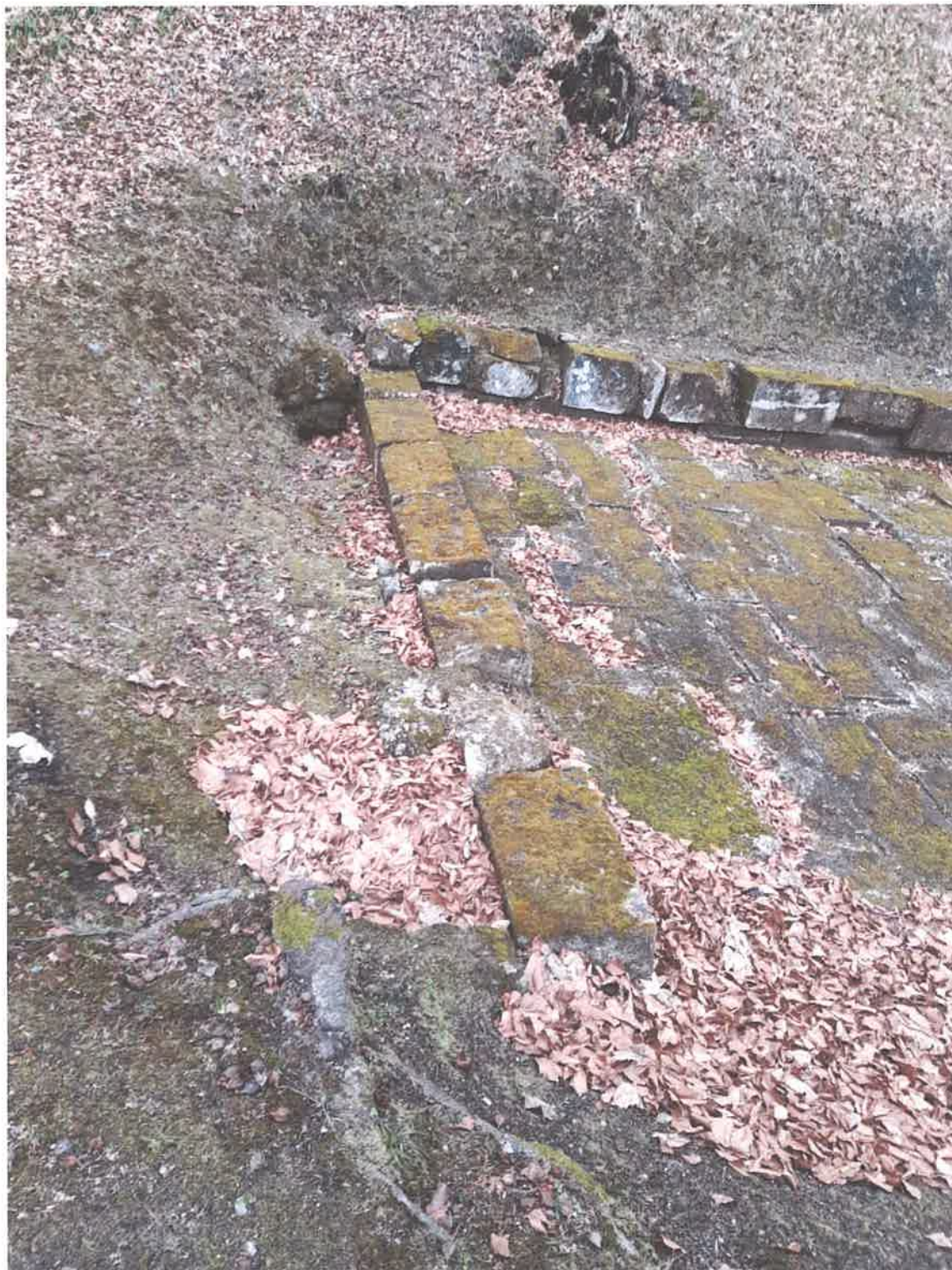
Foto 4 – Vedere de detaliu a Drumului Pavat
