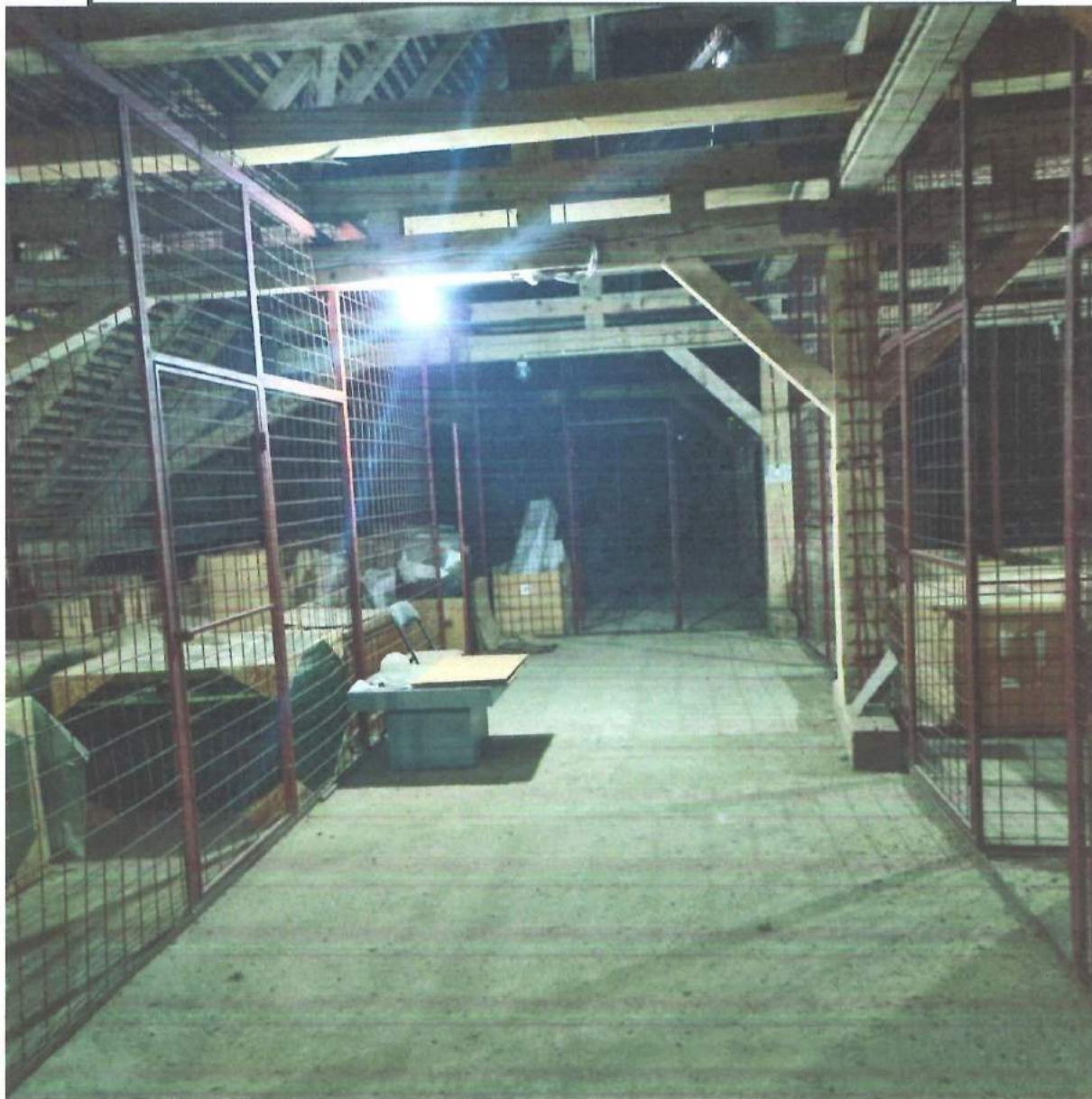
Vedere în pod (Sapa de beton turnată ulterior – se estimează 1980/1990)
