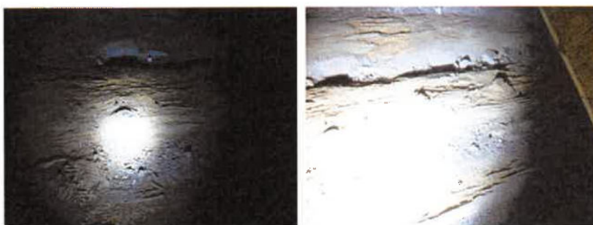
Foto nr.6,7 Grinzi fragilizate de agenți de biodegradare
