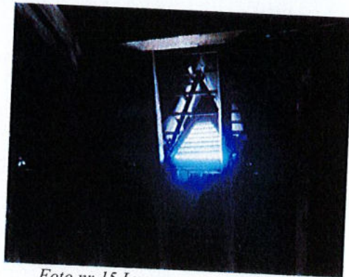
Foto nr.15 Lucarne precar protejate
